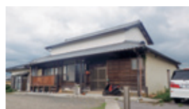
築100年の古民家の リフォーム前
